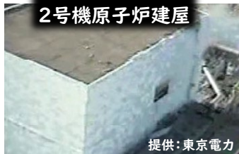
1号機の爆発の衝撃で開いたパネルから水素が外に排出されたため、爆発しなかった。
