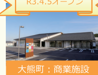
大熊町：商業施設
