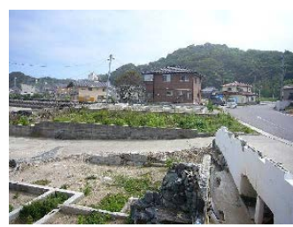
豊間地区着手前状況
