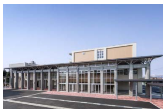
復旧した北校舎東面の様子
